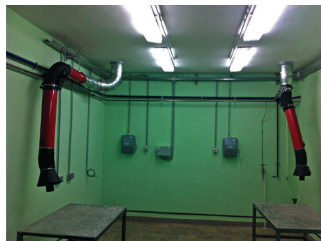
Рис. 3.7. Система вентиляции с использованием полноповоротных воздуховытяжных устройств ПВУ-2-160-ВК с воздухозаборниками типа «конус»
