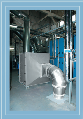
Фильтр для очистки воздуха при пайке и лужении ФПД-10000-1
